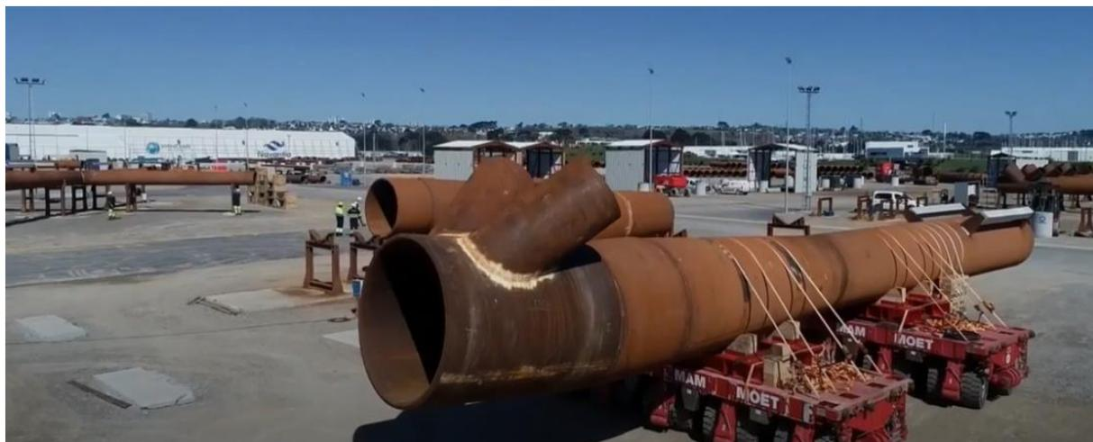
Chargement d'éléments de jacket sur le port de Brest @Ailes Marines - Navantia
