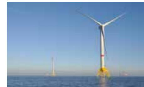
Ailes Marines développe au large de la Baie de Saint-Brieuc (22) un projet de parc éolien en mer de 62 éoliennes, d'une capacité unitaire de 8 Mégawatts (MW). La puissance totale installée du parc sera de 496 MW, pour une production d'énergie de 1 820 GWh par an, correspondant à la consommation électrique annuelle de 835 000 habitants.
