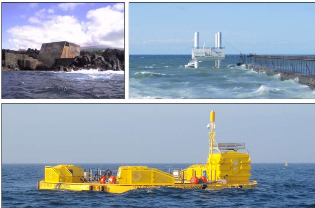
**Figure 3-4** : Exemples d'appareils d'énergie des vagues : la centrale terrestre OWC de Pico aux Açores (source : Pico OWC, 2006) (en haut à gauche), l'appareil en zone côtière Wavestar avec des absorbeurs ponctuels flottants (source : Wavestar, pas de date) (en haut à droite), le « BOLT II Lifesaver » en mer de Fred Olsen (en bas)
